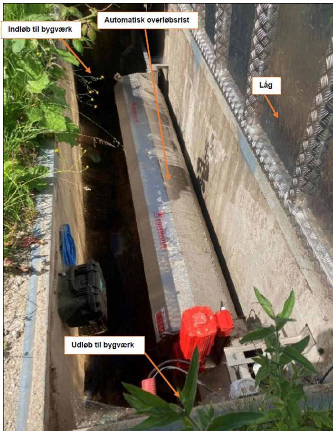
Figur 5. Foto af den nye automatiske rist i overløbsbygværk OV70 Brohaven, Hørning.
